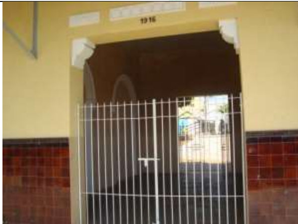
Portão de entrada
